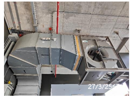
พัดลมระบายอากาศบริเวณชั้นจอดรถ
