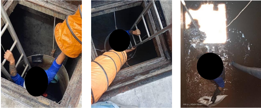
ภาพที่ 2.2-16 การสูบน้ำออกจากบ่อบำบัด
