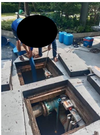
ภาพที่ 2.2-21 การทำความสะอาดบ่อหน่วงน้ำและวางระบายน้ำในโครงการ
