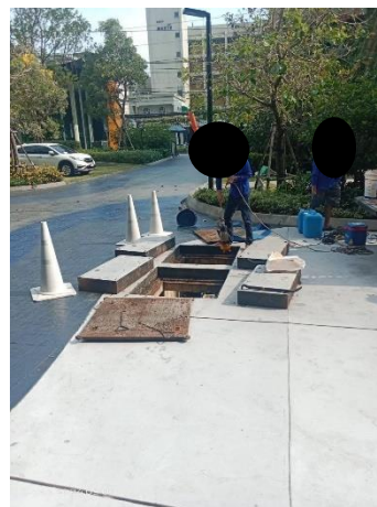
ภาพที่ 2.2-21 การทำความสะอาดบ่อหน่วงน้ำและวางระบายน้ำในโครงการ
