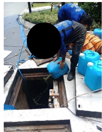
ภาพที่ 2.2-21 การทำความสะอาดบ่อหน่วงน้ำและวางระบายน้ำในโครงการ
